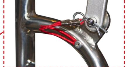
NO OLVIDAR PONER EL CLIP DE SEGURIDAD DE LA BARRA DE REFUERZO.
